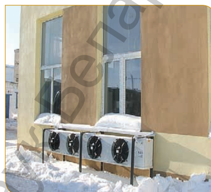
Рис. 4. Экспериментальная теплонасосная установка типа «воздух – воздух» мощностью 35 кВт для обогрева трех производственных помещений пункта технического обслуживания и ремонта тракторов и сельхозмашин
