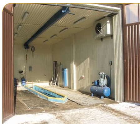
Рис. 4. Экспериментальная теплонасосная установка типа «воздух – воздух» мощностью 35 кВт для обогрева трех производственных помещений пункта технического обслуживания и ремонта тракторов и сельхозмашин
