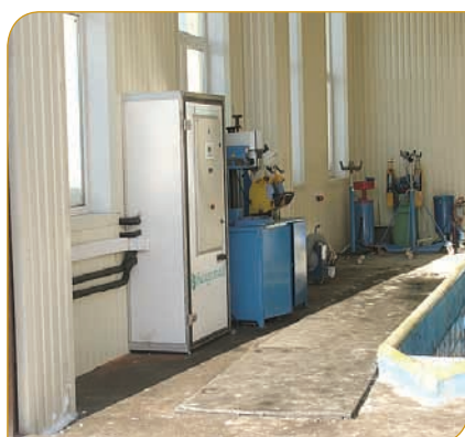
Рис. 4. Экспериментальная теплонасосная установка типа «воздух – воздух» мощностью 35 кВт для обогрева трех производственных помещений пункта технического обслуживания и ремонта тракторов и сельхозмашин
