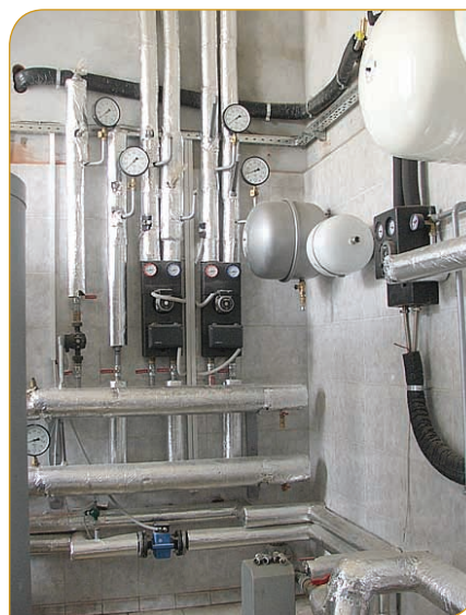
Рис. 1. Элементы системы обогрева и горячего водоснабжения бытовых помещений с применением теплового насоса мощностью 33,6 кВт
