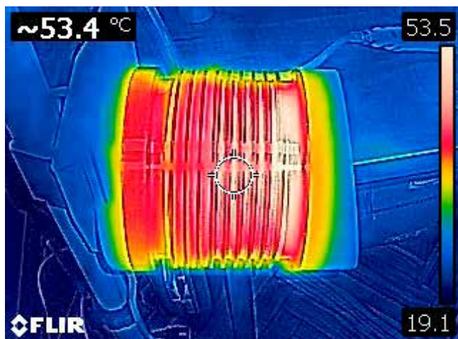
Рис. 7. Тепловизионный контроль степени разогрева дыхательного контура
